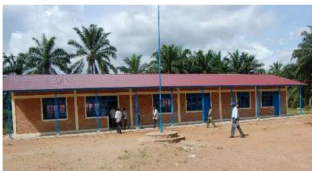
Slika 5: Učionice sa pristupom u ravni tla – škola u Burundiju. (Izvor: UNICEF)
